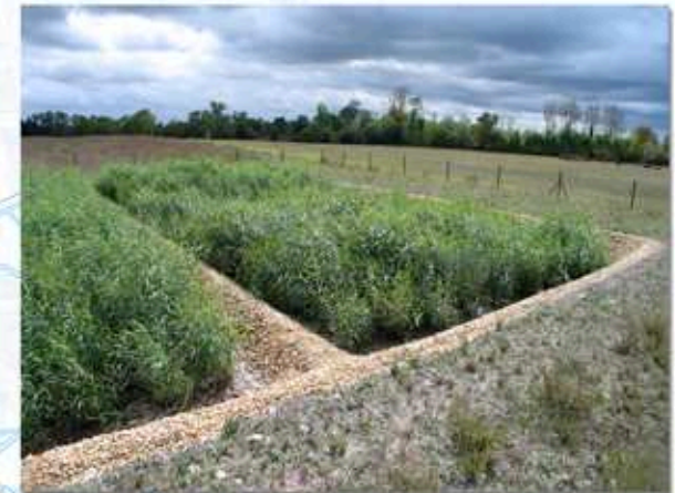
FILTRES PLANTÉS DE ROSEAUX (160 EH)
